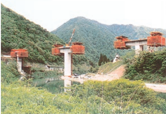
東海北陸自動車道 五箇山橋
