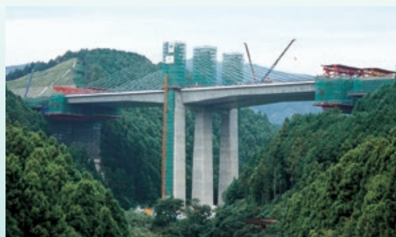
新東名高速道路 都田川橋
