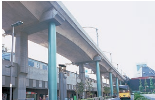
JR中央線東京駅付近重層化PC高架橋
